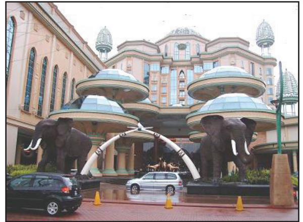
Foto 9: Pembangunan hotel di Sunway Pyramid, Selangor, (Mac 2007).
