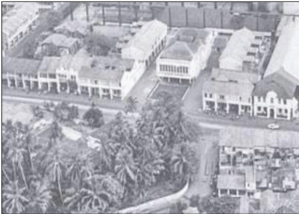
Foto 36: Sebelum pembangunan semula. (Sumber: http://penangtimessquare.com/nov2006 )
